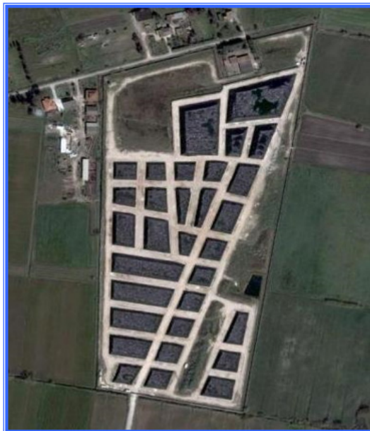
Foto 4 – Vista satellitare sito di Brezza-Capua (CE)
