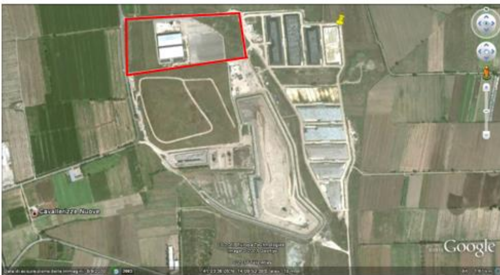
Foto 13 – Vista satellitare impianto di compostaggio (S. Tammaro CE)
